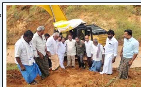
లదపల్లి గ్రామ సమీపంలో హంద్రీగివా కాలువ పనులను పరిశీలిస్తున్న మాజీ ఎమ్మెల్యే గుండుమల
