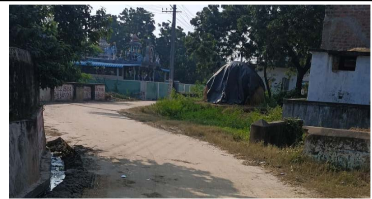
పంచాయతీలో జరిగిన సిమెంట్ రోడ్డు పనులు
