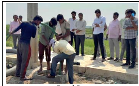
సైఫల్ డ్రైనేజ్ పనులను పర్యవేక్షిస్తున్న ఎమ్మెల్యే అప్పిత్ రెడ్డి
